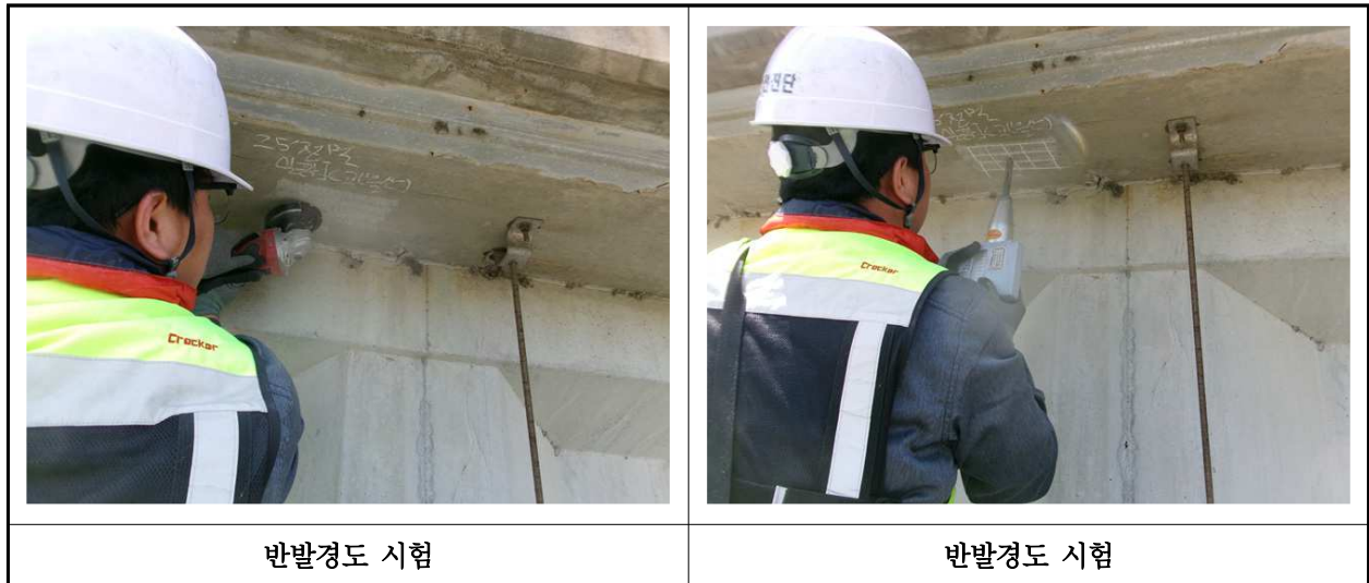
【사진 39.4.2】 반발경도시험 현장사진
