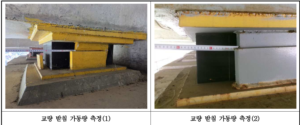
【사진 39.3.16】 교량받침 이동량 측정
