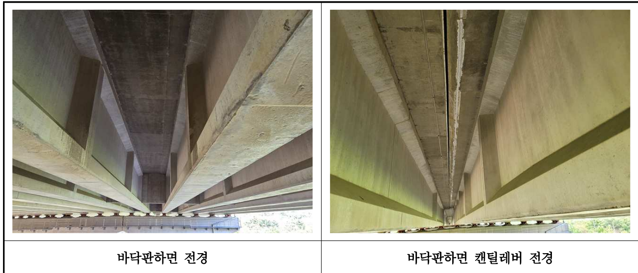
【사진 39.3.2】 바닥판하면 전경
