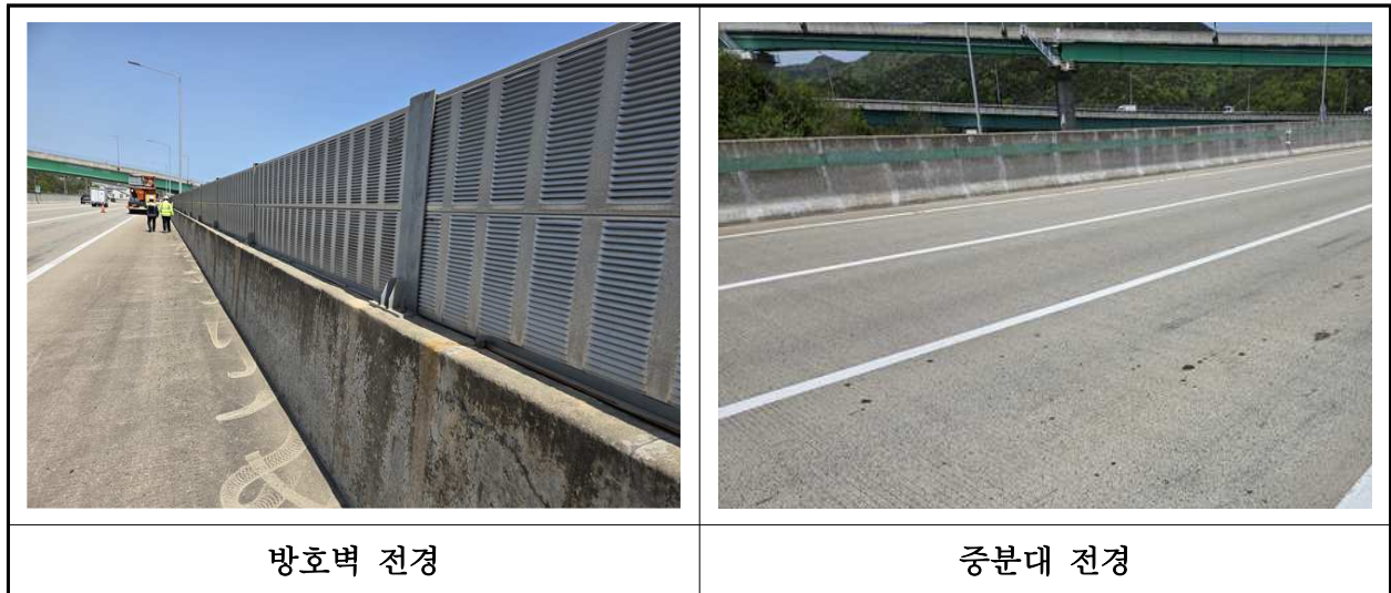
【사진 39.3.24】 방호벽 및 중분대 전경
