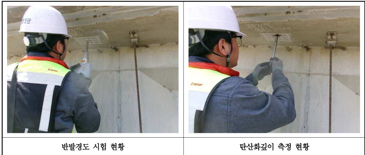
【사진 39.4.1】 콘크리트 내구성조사 현황
