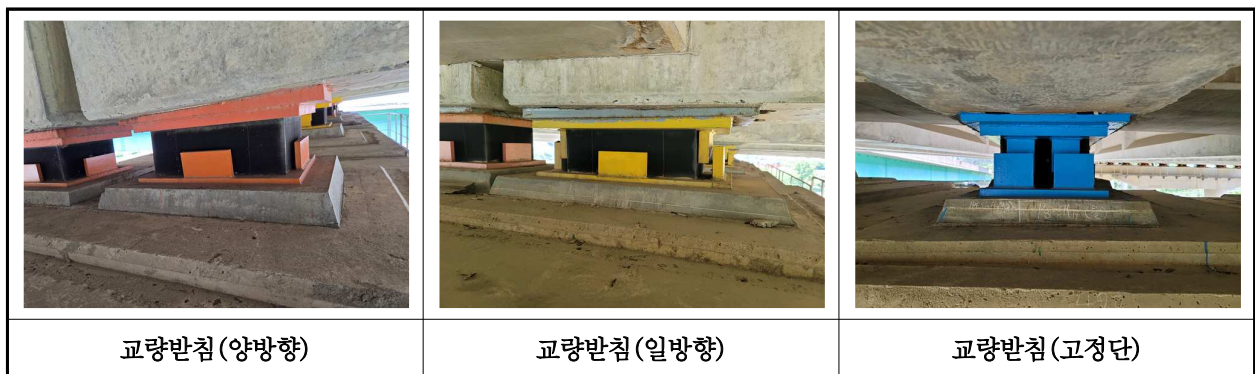
【사진 39.3.13】 교량받침 전경
