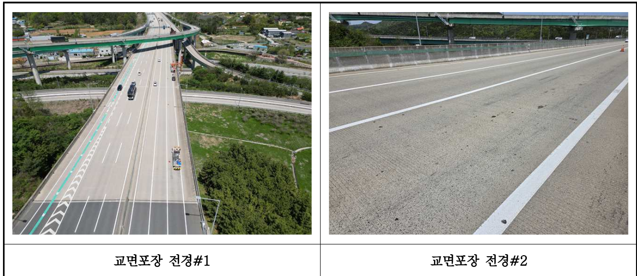
【사진 39.3.20】 교면포장 전경
