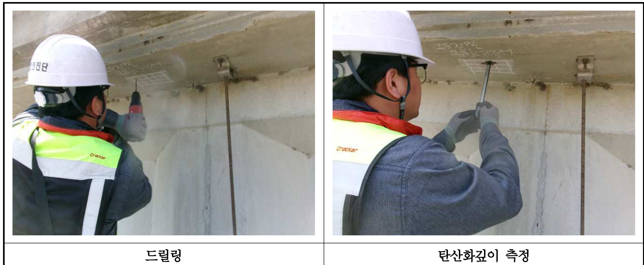
【사진 39.4.3】 탄산화 깊이 측정 현장사진
