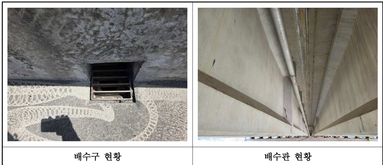
【사진 39.3.22】 배수시설 전경
