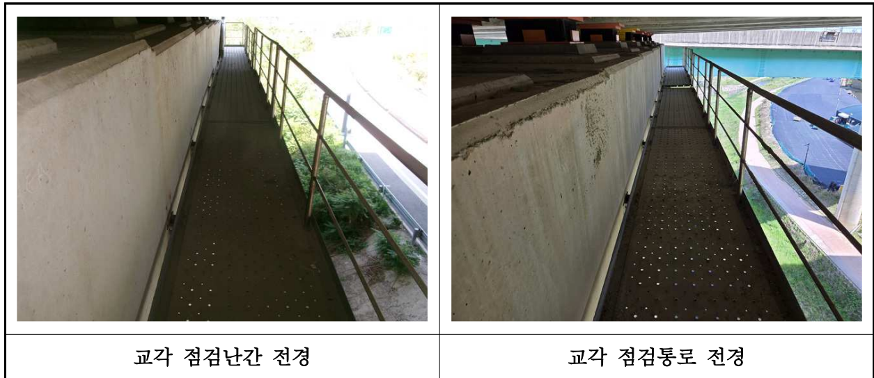
【사진 39.3.26】 교량 점검시설 전경
