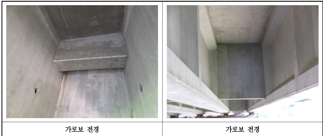
【사진 39.3.6】 가로보 전경
