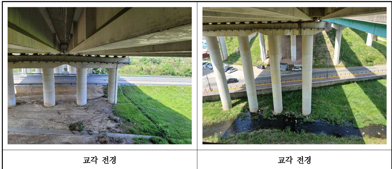
【사진 39.3.10】 교각 전경
