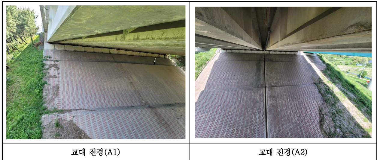
【사진 39.3.8】 교대 전경
