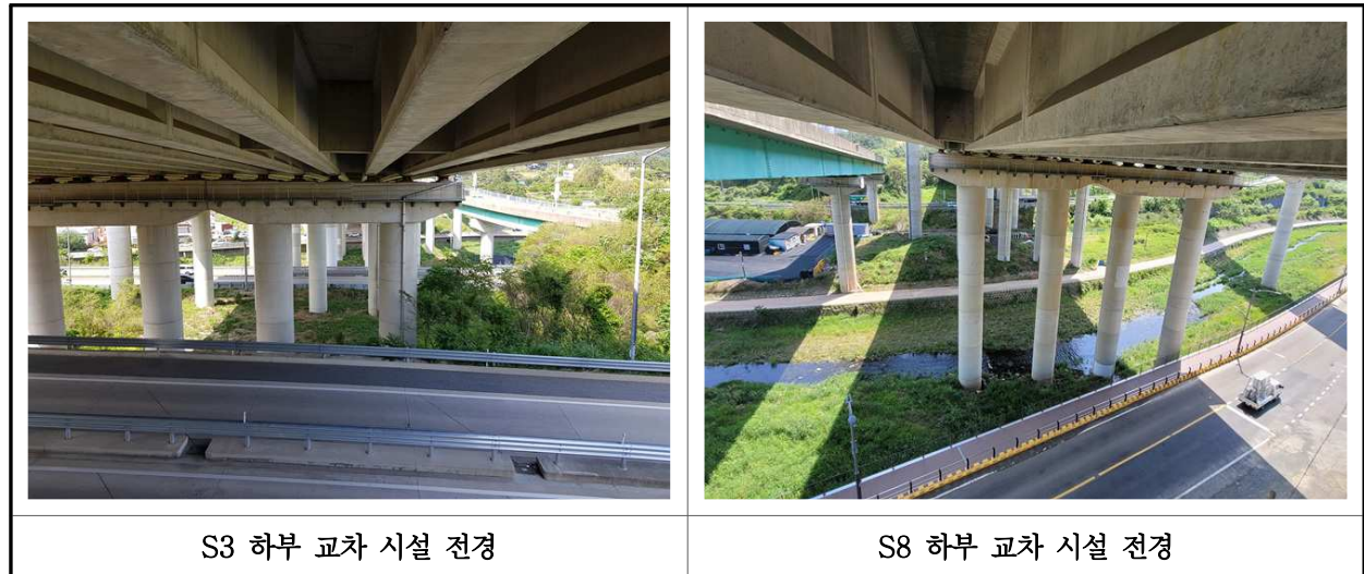
【사진 39.2.1】 주변환경 및 하중변화 전경(계속)
