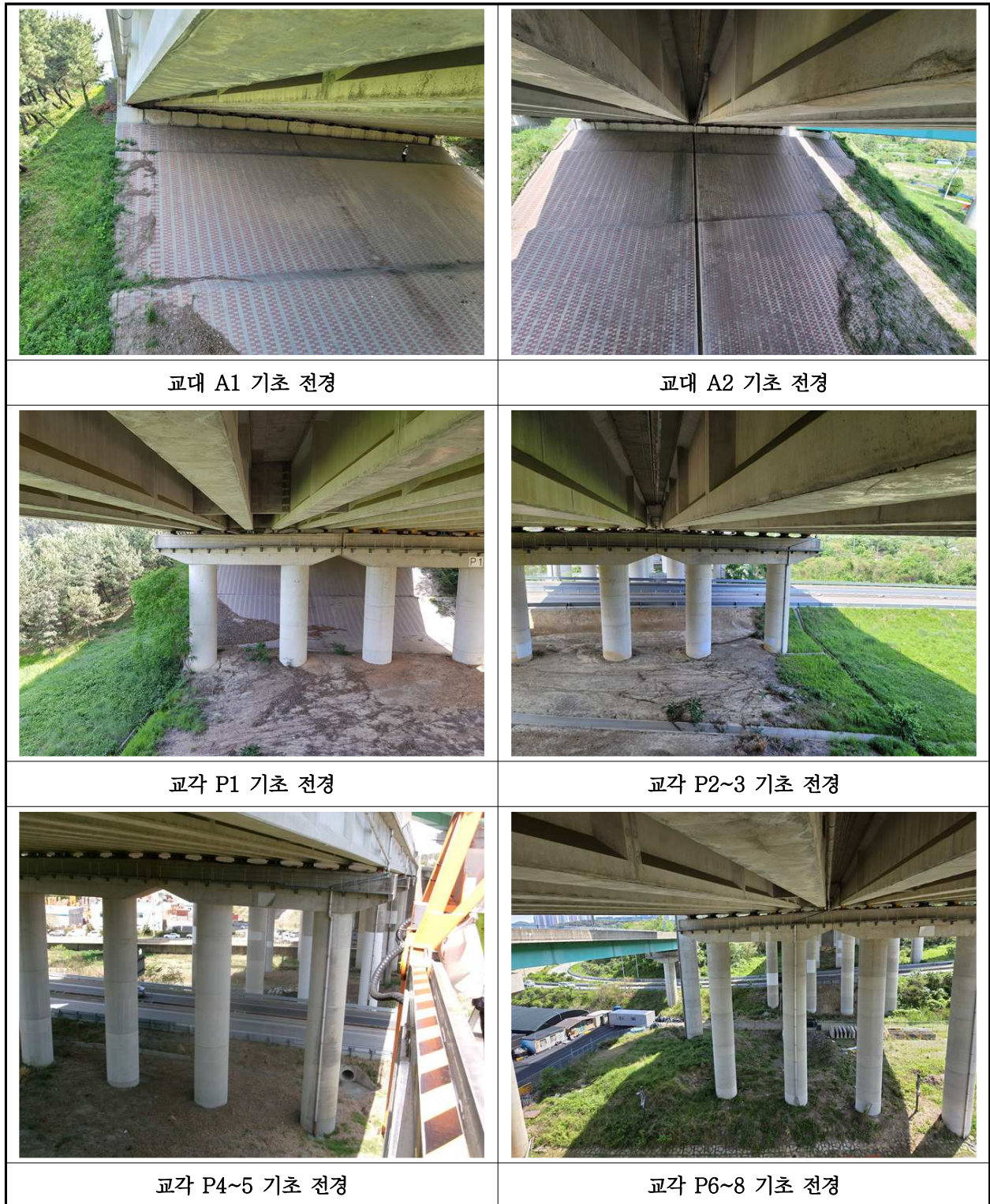
【사진 39.3.12】 기초 전경
